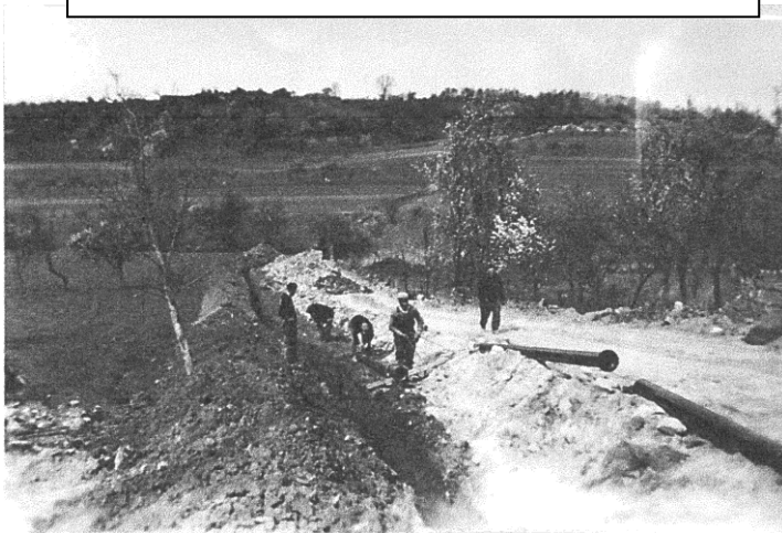
Réalisation de la conduite d'eau 1961/1962
